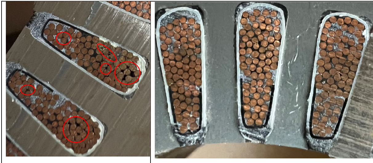
Bild 4: Vergleich der Imprägnierqualität eines nicht vortemperierten Elektromotors (links) und eines vortemperierten Elektromotors (rechts)
